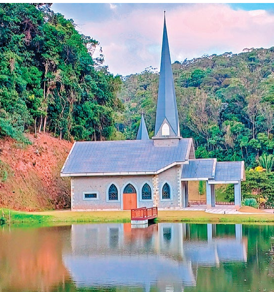
A capela ecumênica do centro de turismo foi concluída e já está aberta para os hóspedes. Em breve, contará com agendamento de casamentos e outras cerimônias
